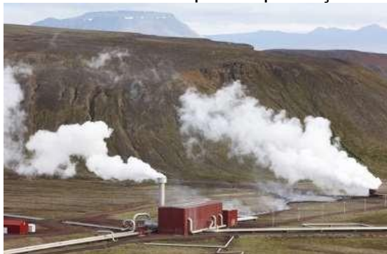
Usina de energia geotérmica
