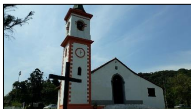
Igreja do Pilar
